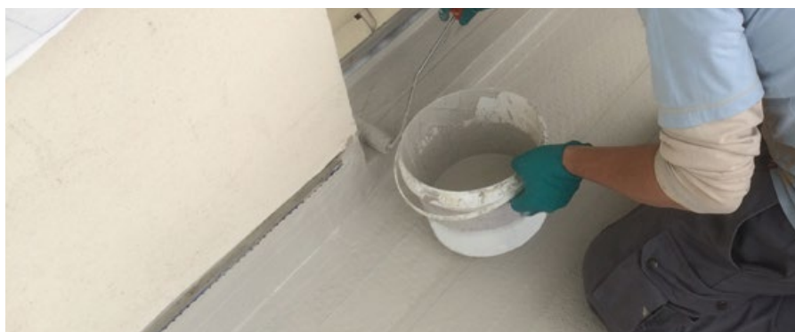
Wecryl R 230 thix - Für An- und Abschlüsse sowie Details
