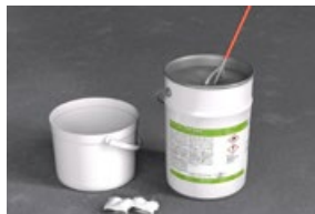
1. Abdichtungsharz vorgängig im Eimer gründlich aufrühren
