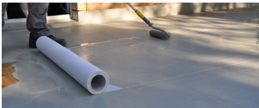
Wecryl R 230 - Flächenabdichtung mit Vlies
